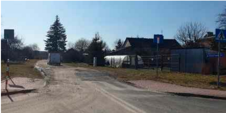
Niewykluczone, że budowę ulicy Popiełuszki uda się rozpocząć jeszcze w tym roku
