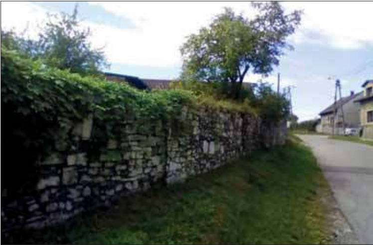
Fragment muru dworskiego. Stan obecny
