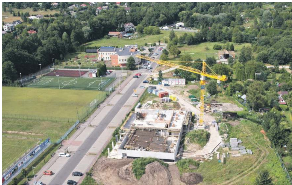
Trwa budowa basenu w Krzeszowicach
