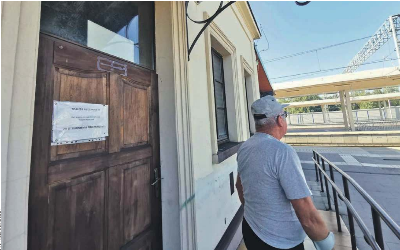
Toaleta publiczna w budynku dworca kolejowego w Trzebinii pozostaje nieczynna
