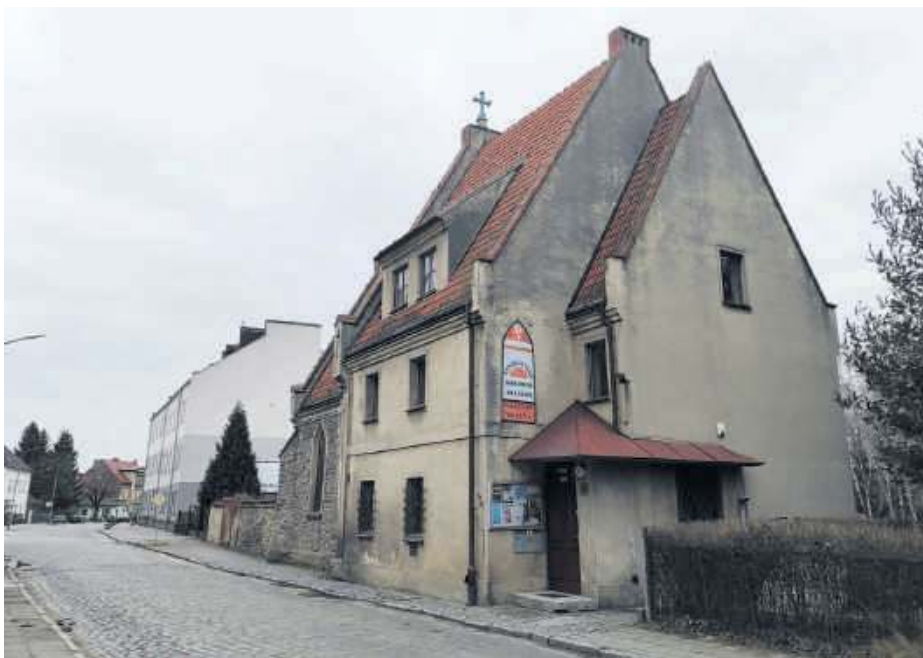
Kaplica Szpitalna pw. Św. Jerzego przy ulicy Brzegowej w Strzelinie, dawna siedziba Strzelińskiego Ośrodka Kultury
