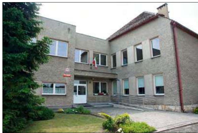
Termomodernizacja zapewni nie tylko nowy wygląd, ale również może o ponad połowę zmniejszyć koszty energii.
