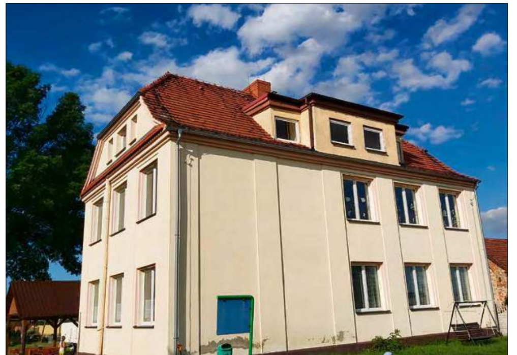
Budynek przejdzie termomodernizację.
