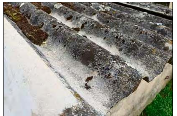
Płyty azbestowe zostaną zdjęte z dachów budynków mieszkalnych i gospodarczych, z podestów, osłon balkonowych i przyz.
