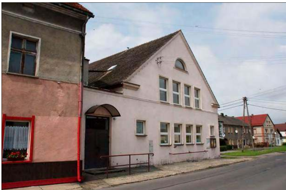
Cały budynek zostanie przebudowany. Zmieni się jego elewacja i wnętrze.
