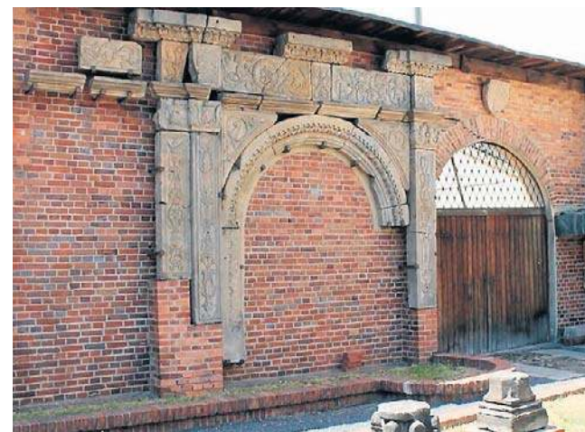
Zachowany fragment portalu, zmontowany i eksponowany w legnickim lapidarium
