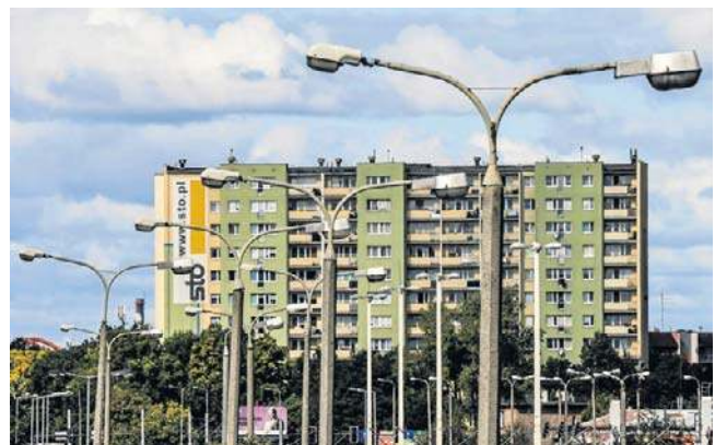
W Bydgoszczy trwa wielka wymiana ulicznego oświetlenia. Powstać ma około 11 tysięcy nowych punktów świetlnych LED, które zastąpią stare latarnie
