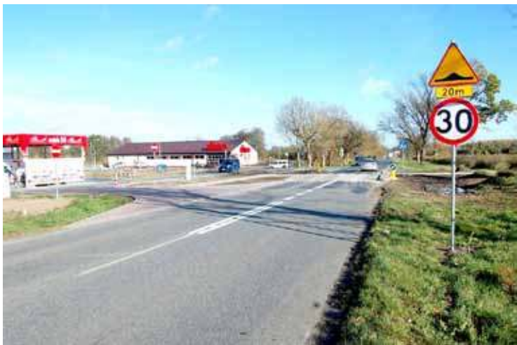
Zakończyła się budowa przejścia dla pieszych pozwalającego dojść do marketu Dino w Morzyczynie
