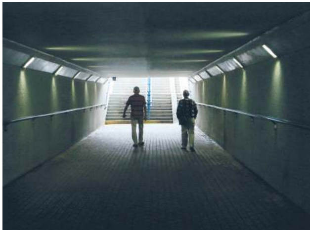
Przejście pod torami przy ul. Targowej to nie jedyne miejsce w Świdniku, gdzie po ulewnych deszczach pojawia się woda
