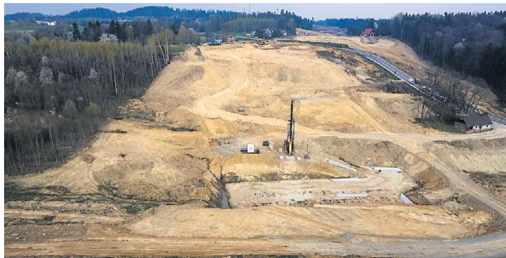
W momencie zerwania kontraktu zaawansowanie prac na odcinku S19 Domaradz – Krosno wynosiło 13 procent. Termin zakończenia tej inwestycji minął w czerwcu br.
