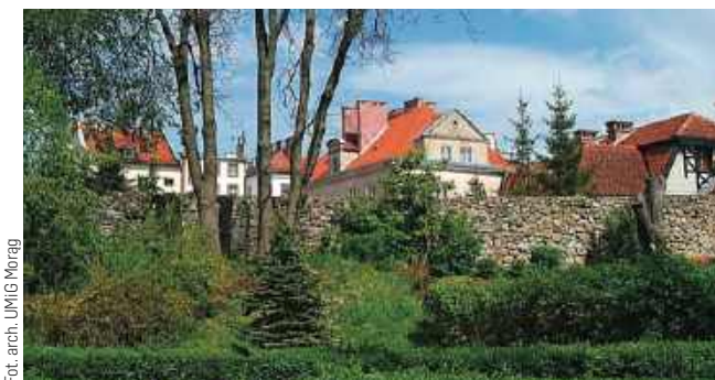
Średniowieczne mury obronne w Morągu i uszkodzony fragment
