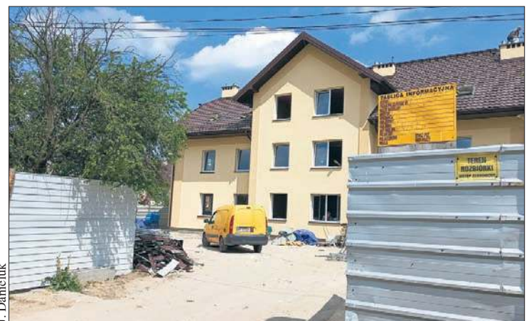
Na osiedlu Miodowa Jar dobiega końca budowa dziesiątego bloku mieszkalnego
