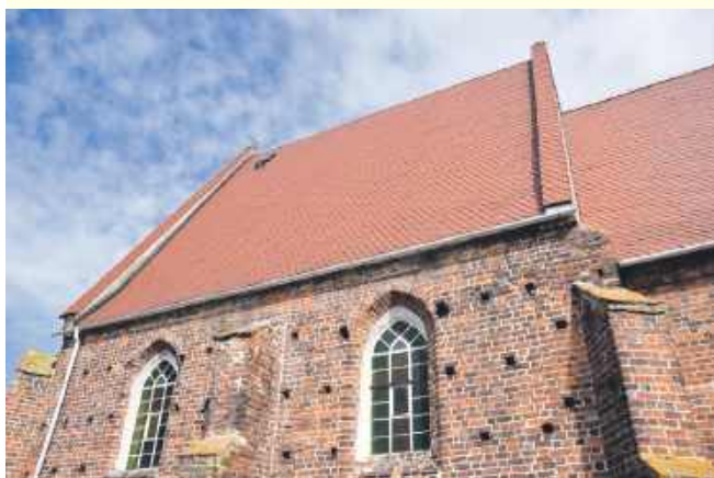
Ukończono remont dachu XV-wiecznego kościoła w Ozorowicach
