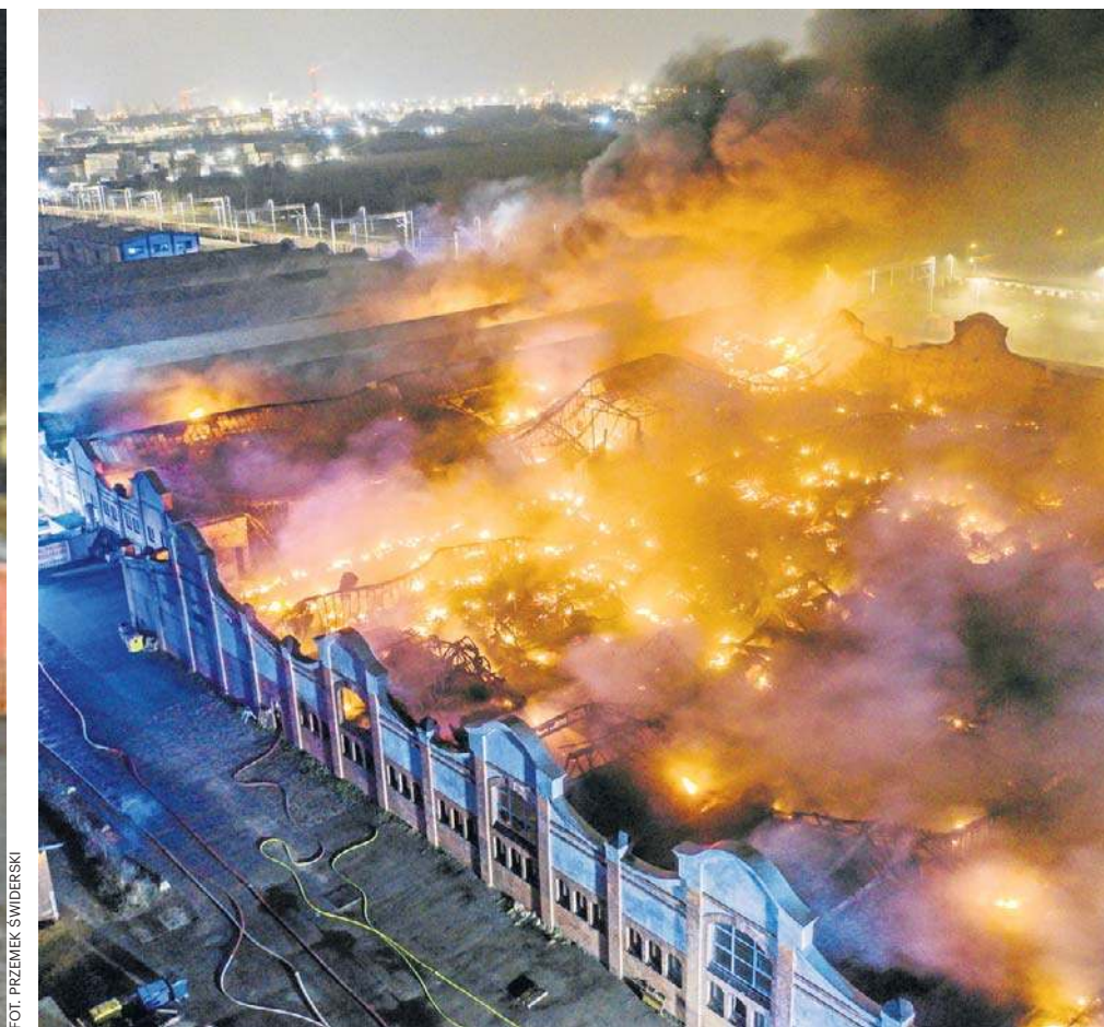
W lutym pożar zniszczył halę na Przeróbce. Ogień wybuchł w nielegalnej fabryce narkotyków, która znajdowała się w tym miejscu i rozprzestrzenił się na cały obiekt
