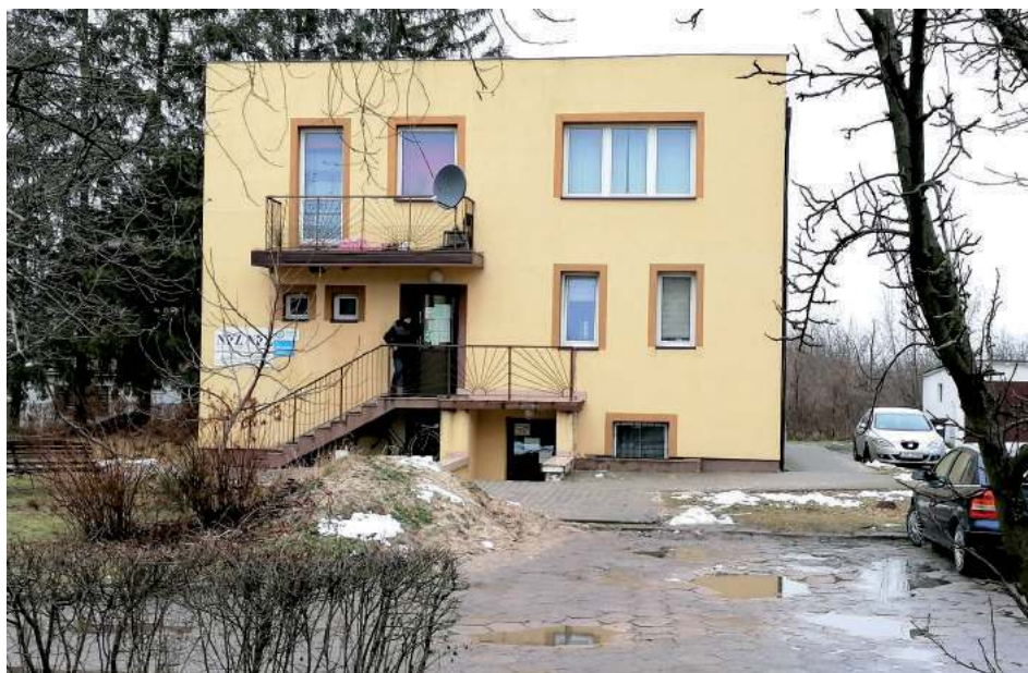
Choć Ośrodek Zdrowia w Urzędzkowie działa od ponad 30 lat, to niepełnosprawni pacjenci mieli utrudniony dostęp do lekarzy. Po schodach trudno było dostać się do środka osobom poruszającym się na wózku inwalidzkim
