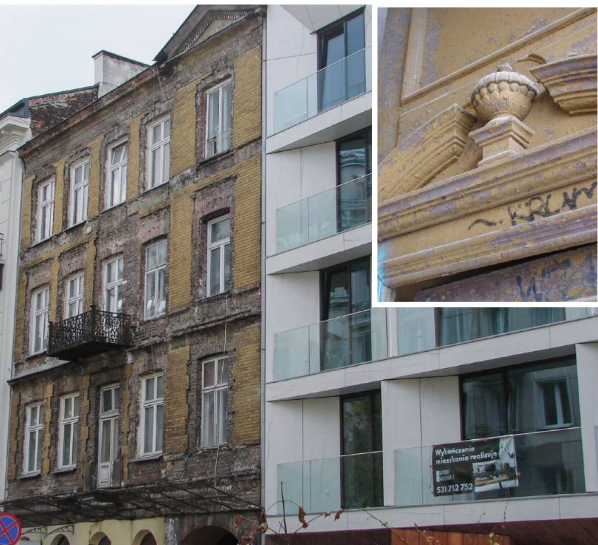
Kamienica nr 13 na tle odnowionej i uzupełnionej zabudowy ul. Emilii Plater oraz fragment dekoracji drewnianych wrót bramy | fot. Janusz Sujecki/Gazeta Polska
