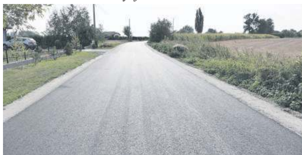
Prace związane z przebudową gminnej drogi są już na ukończeniu
