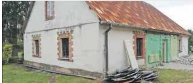
Remont i przebudowa muzeum idzie pełną parą
