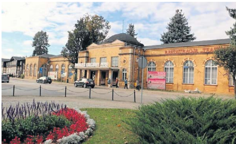
Dworzec do połowy 2028 roku ma przejść gruntowny remont
