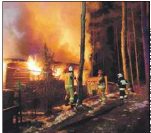
Spaleniu uległa praktycznie cała konstrukcja budynku i jego wyposażenie
