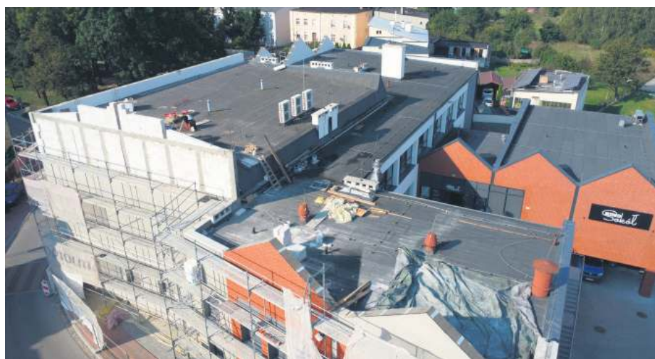
W ramach inwestycji przebudowywany jest też dach.
