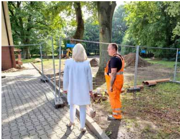
Wójt Gminy Sylwia Kalmus-Samsel przybyła do Chlebówka by zobaczyć jak idą prace związane z budową oczyszczalni ścieków przy szkole podstawowej w Chlebówku
