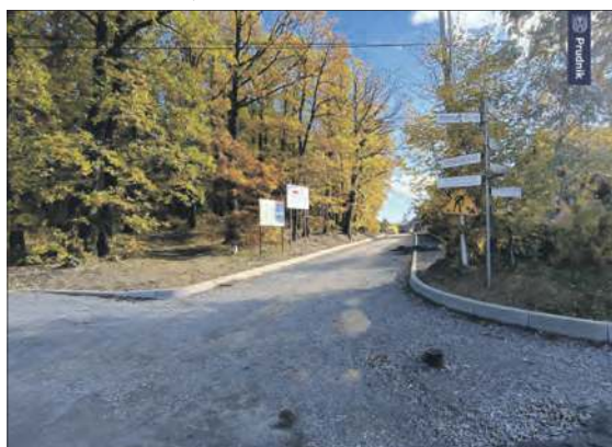
Droga w Dębowcu
