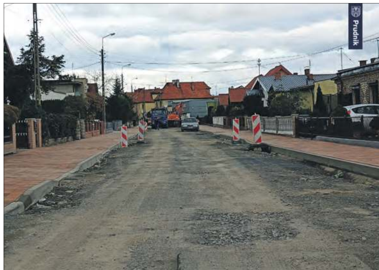
Ulica Asnyka w Prudniku
