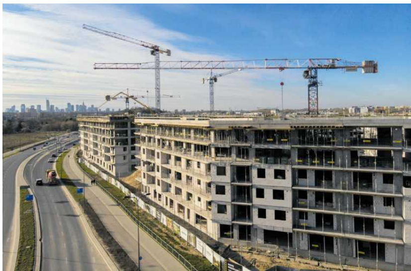
• Budowa osiedli, Warszawa, marzec 2023 r. FOT. ADAM STĘPIEŃ / AGENCJA WYBORCZA.PL
