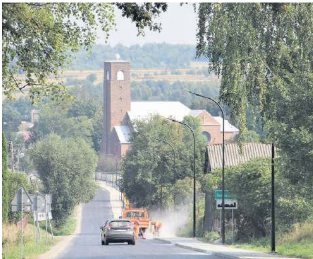
Równiutka droga i nowy chodnik w Suchowoli. Jednak prace wykończeniowe jeszcze trwają.
