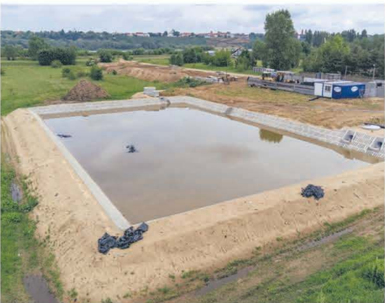
Trwa budowa zbiornika retencyjnego na osiedlu Radziwie
