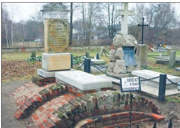
➤ Fazę konserwacji przechodzi obecnie piwnica grobowa nagrobka Falińskich
