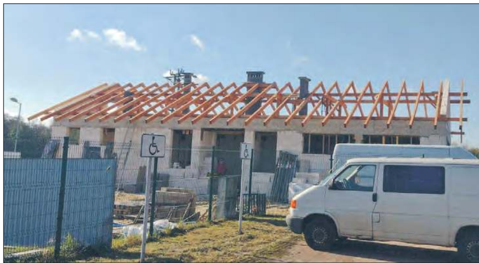
■ Postępy w budowie zaplecza na stadionie w Sobieszynie są już wyraźnie widoczne. Umowa z wykonawcą została podpisana w sierpniu, a na realizację inwestycji przewidziano 11 miesięcy. W tym czasie firma zobowiązała się do wybudowania i pełnego wyposażenia obiektu (fot. Urząd Gminy Ułęż)
