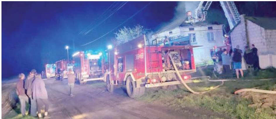
Straty oszacowane zostały na kwotę 50 tys. zł. Spaleniu uległa konstrukcja dachu
