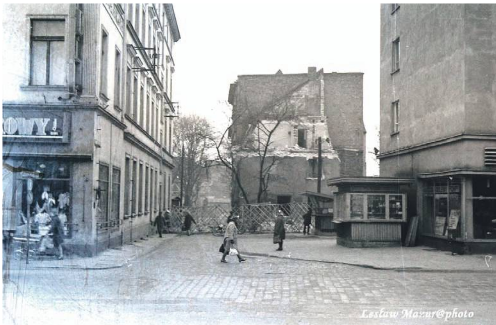
10. Rok 1969 - ściana wschodnia Rynku, na wprost ulica B. Głowackiego, w głębi trwa rozbiórka budynków mieszkalnych, w poprzek powstanie tam budynek przy dzisiejszym pl. J. Piłsudskiego). Po lewej Dom Towarowy, a po prawej kiosk Ruchu i część witryny, gdzie był sklep Rolnik. Fot. Lesław Mazur
