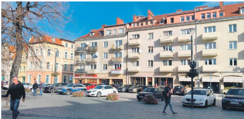
Rok 2023 - dzisiejsza pierzeja wschodnia po remoncie nawierzchni placu rynkowego, strona środkowa. Fot. Lesław Mazur
