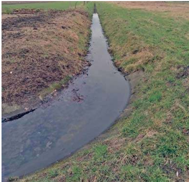
Ostatnio na Starym Żabnie oczyszczono i udrożniono cztery kluczowe rowy melioracyjne
