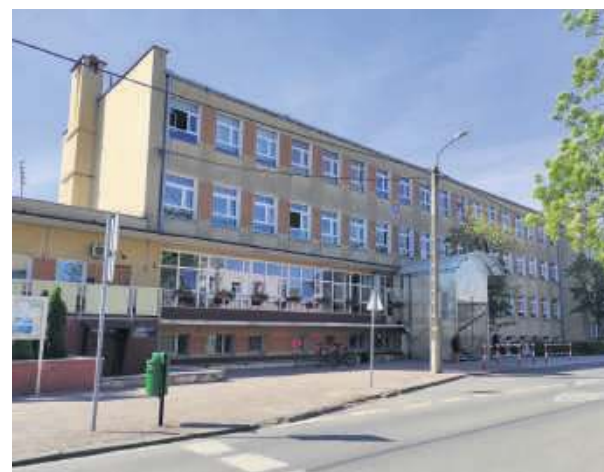
W ramach termomodernizacji Szkoły Podstawowej nr 4 w Strzelinie zostanie zamontowana winda zewnętrzna dla osób niepełnosprawnych
