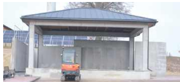
Na ukończeniu są prace związane z budową sceny widowiskowej (amfiteatru) przy ośrodku kultury w Ułężu. W tej części placu stoją też już ławki
