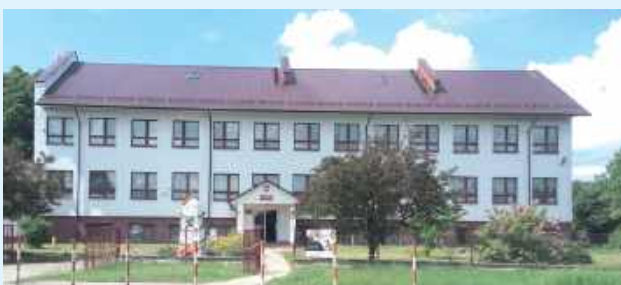
Samorządowy Żłobek „Berek” powstanie w budynku Szkoły Podstawowej w Wywłoczce
