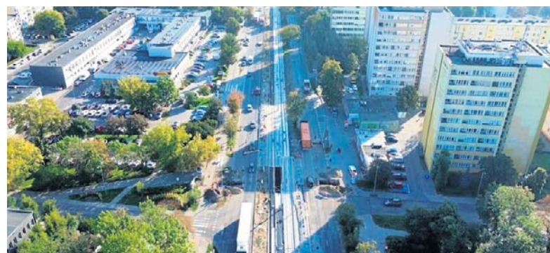
Na ulicy Kościuszki trwa wymiana asfaltowej nawierzchni
