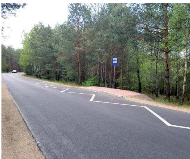
2 czerwca odbył się odbiór końcowy zmodernizowanej drogi powiatowej Nr 1437L na odcinku Niebrzegów - DW 845. Po dotychczas i pofalowanym asfalcie nie ma śladu
