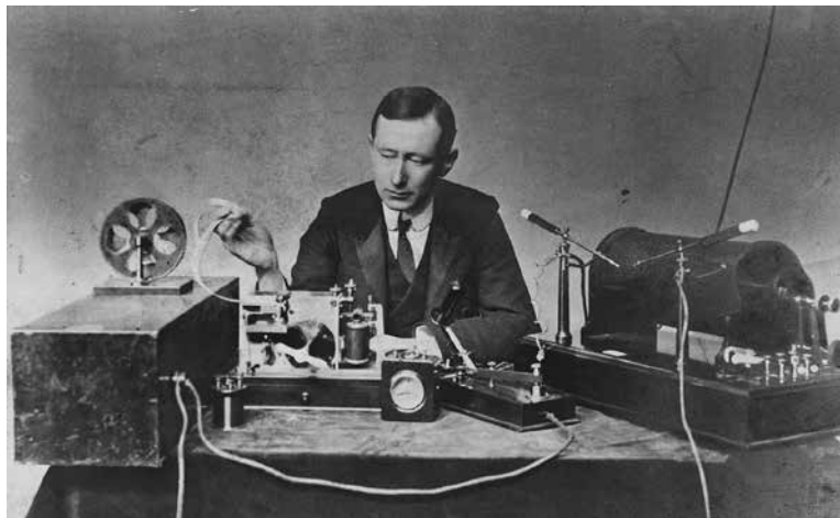
Rok 1901, Marconi; po jego prawej stronie nadajnik iskrowy, po lewej odbiornik na kohererze z zapisem na taśmie papierowej
