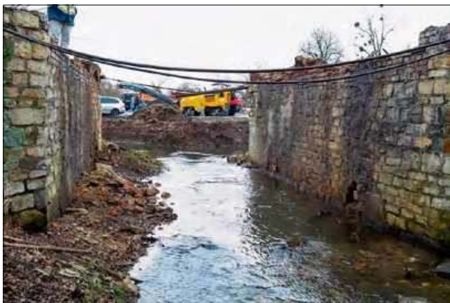
Stary most został rozebrany, a w jego miejsce powstanie nowa konstrukcja.
