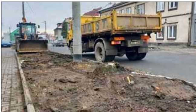
Trwają prace przygotowawcze do przebudowy.
