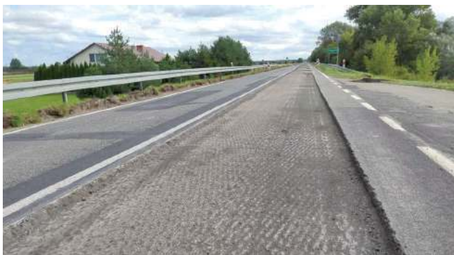
Drogowcy zdejmują starą, pofałdowaną nawierzchnię i kładą nowy dywanik asfaltowy
