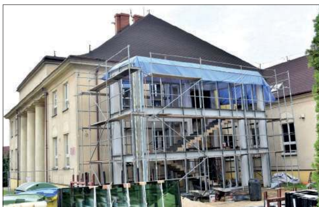
Do połowy października ma trwać budowa dodatkowej, przeszklonej klatki schodowej z windą w SP Łaziska
