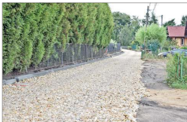
Trwają intensywne prace związane z przebudową ulicy Granicznej/Poprzecznej w Gołkowicach i Skrbeńsku
