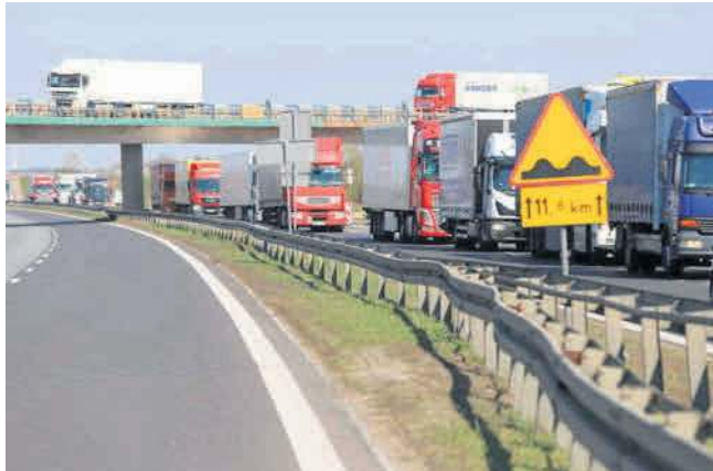
Prace na odcinku Piotrków - Kamieńsk zaczną się w czwartek. Na pozostałych odcinkach w Łódzkiem roboty już trwają
