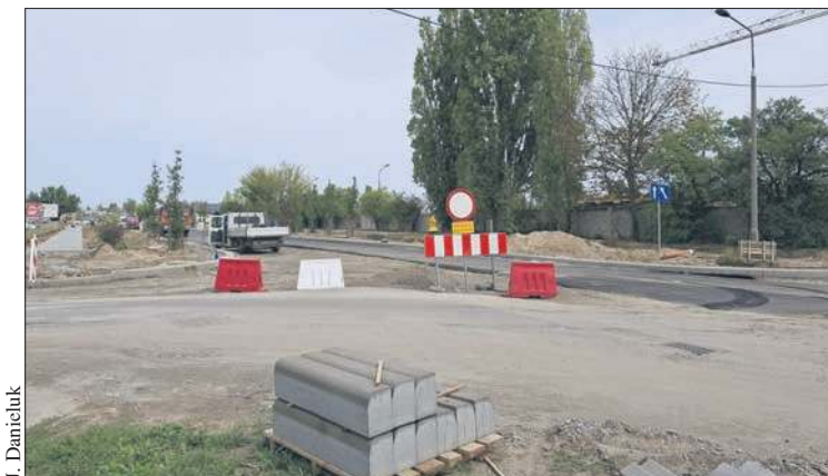
Trwa przebudowa ul. Przemysłowej
