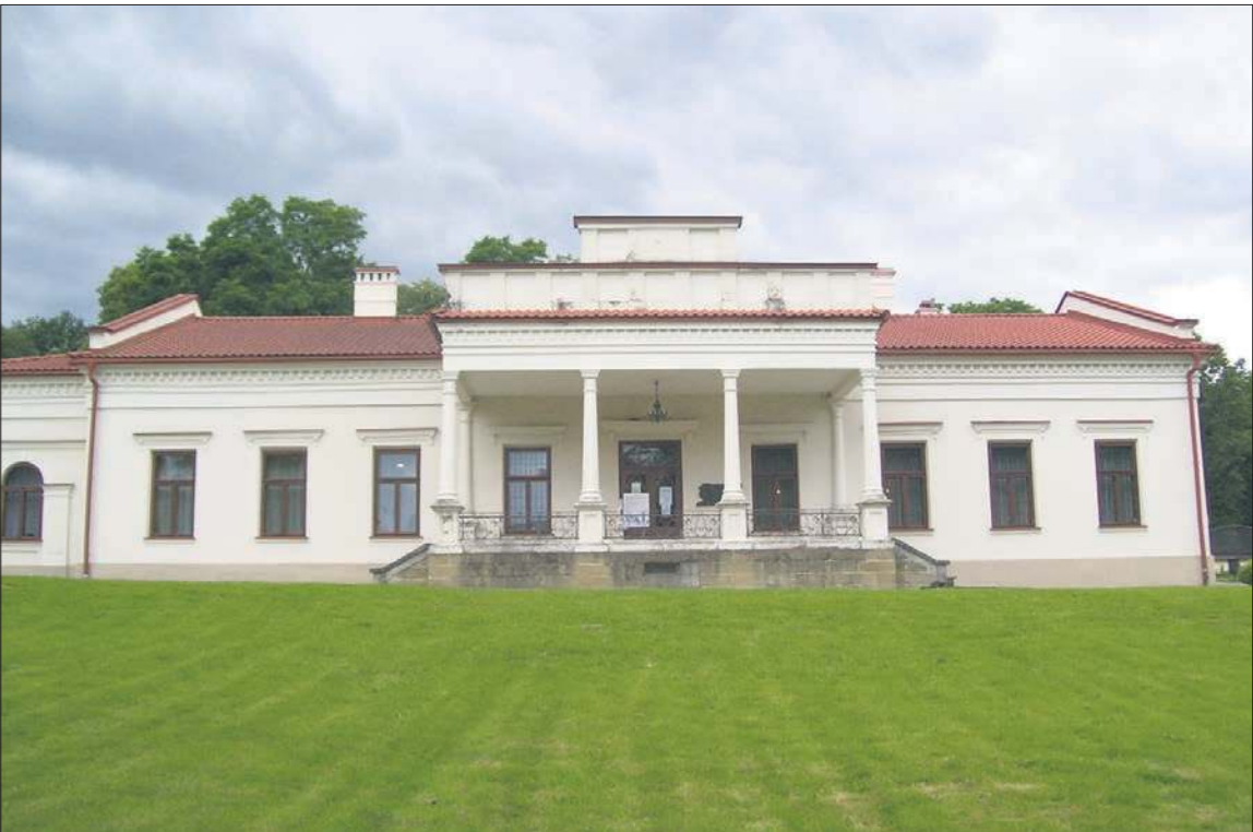
Dwór Ignacego Paderewskiego w Kąsnej Dolnej
