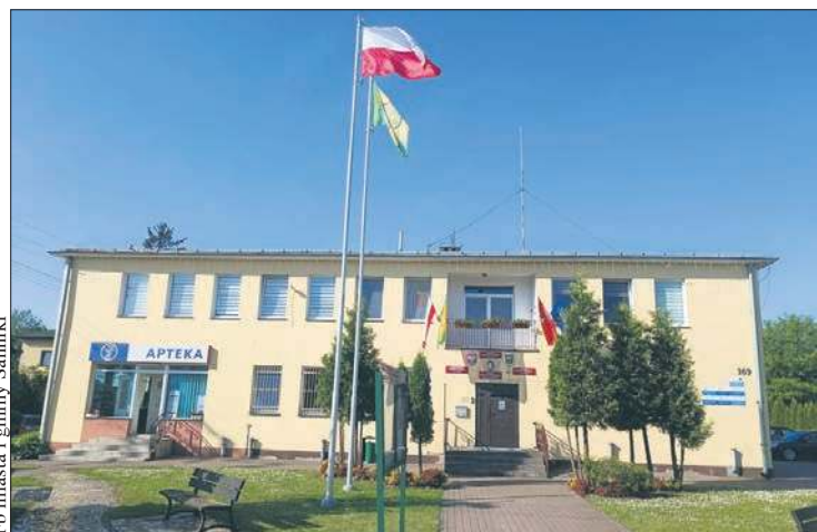
Sanniki zbudują energooszczędne oświetlenie uliczne
