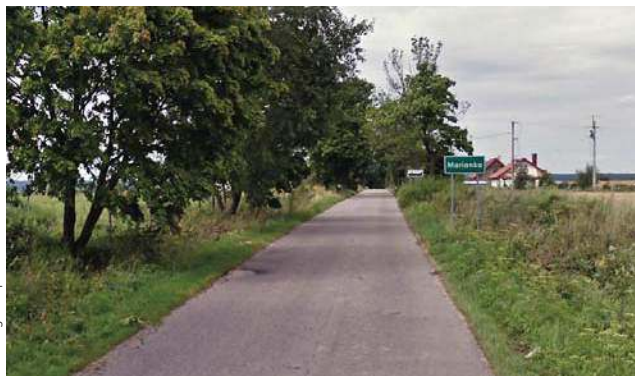
Korzystanie z tej drogi stało się niezwykle uciążliwe i niebezpieczne dla pieszych
