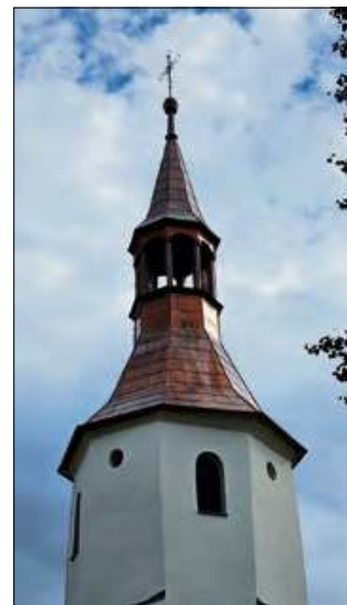
Pokrycie dachu wieży też zostało wymienione.
