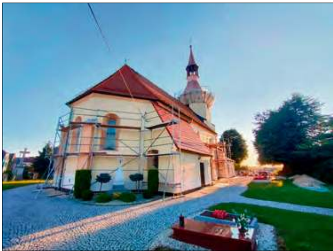
Remont elewacji kosztował prawie 130 tysięcy złotych.
