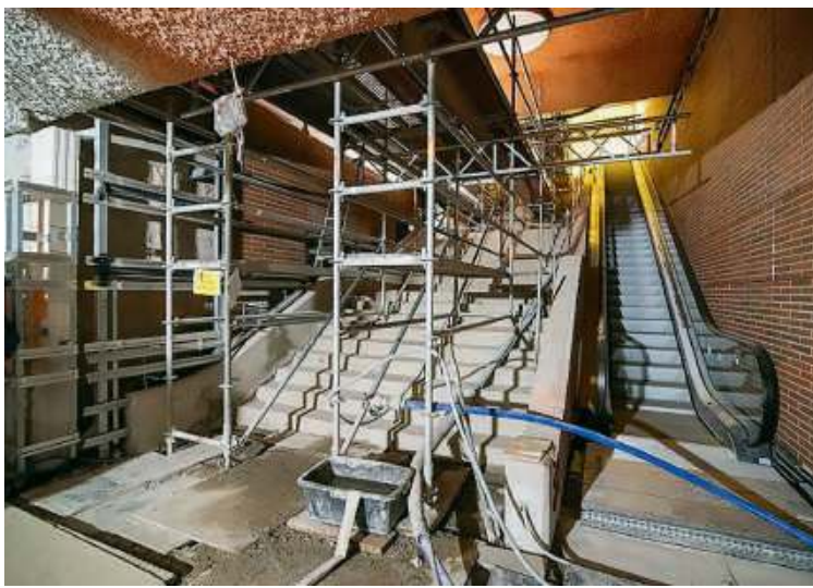
Budowa stacji C04 Bemowo | fot. Um.warszawa.pl/d
