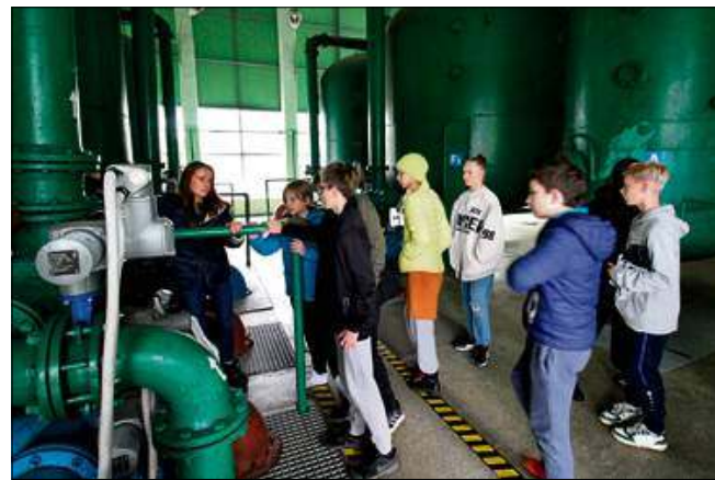
Zwiedzanie stacji uzdatniania wody.
