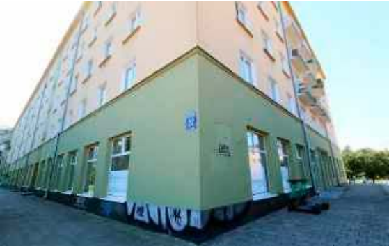
Na parterze budynku przy Alejach Racławickich 22 wszystko jest już gotowe na przyjęcie pierwszych czytelników
