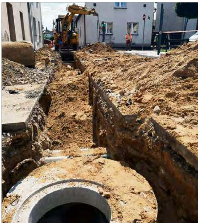
Warunkiem umowy jest również wymiana części sieci kanalizacji deszczowej.
