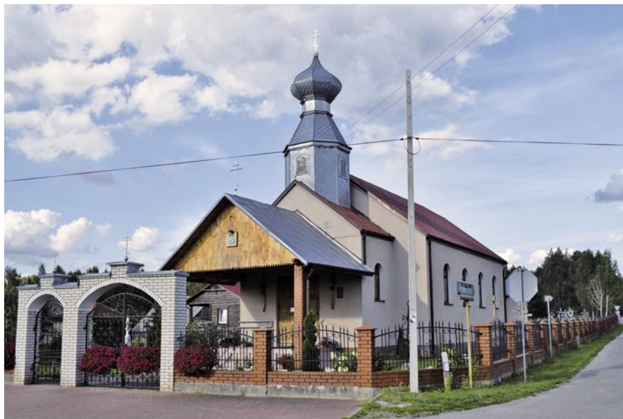
Cerkiew cmentarna w Kuzawie spłonęła przed I wojną światową. Na zdjęciu budynek cerkwi parafialnej pw. św. Barbary, wzniesiony na jej miejscu w latach 70. XX w.
