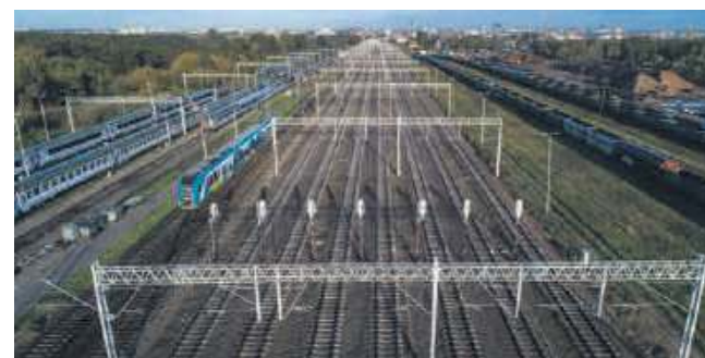
Prace kolejowe w porcie Szczecin i Świnoujście wpłyną na rozwój gospodarki regionu
