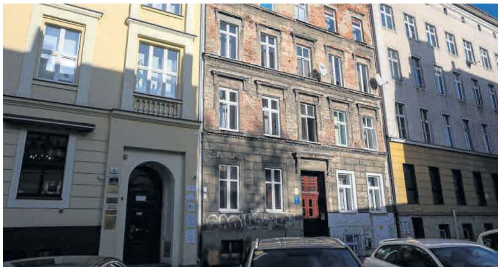
Realizację projektu rozpoczęto od badań dwóch kamienic położonych na terenie Nowego Miasta, przy ul. Stośława 1 (na zdjęciu w środku) i Kaszubskiej 34
